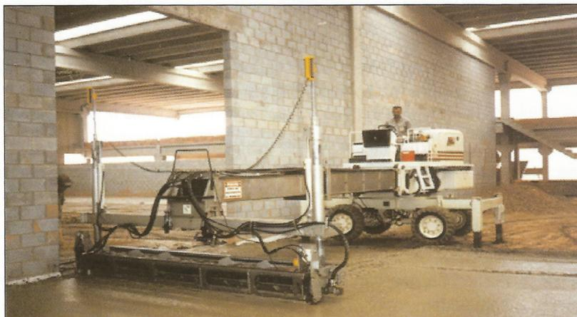
Figura 9.3: Equipamento Laser Screed
