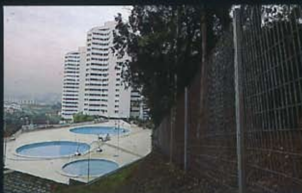
CONJUNTO HABITACIONAL L'ABITARE - SP. Alambrado de segurança e fechamento (malha: 15 x 5 cm fio: 3,0 mm)
