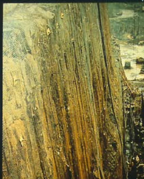
USINA HIDRELÉTRICA DE ITAIPU Contenção de encostas (malha: 5 x 5 cm fio: 3,4 mm)
