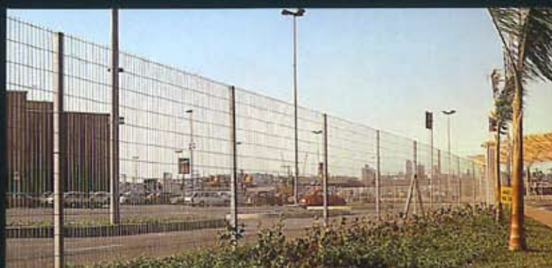
"SHOPPING CENTER NORTE" - SP. Alambrado de fechamento, apresentando ótima estética visual (malha: 15 x 5 cm fio: 3,4 mm)
