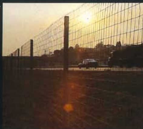
RODOVIA DOS TRABALHADORES - SP. Proteção contra passagem de pedestres e animais (malha: 10 x 5 cm fio: 2,7 mm)
