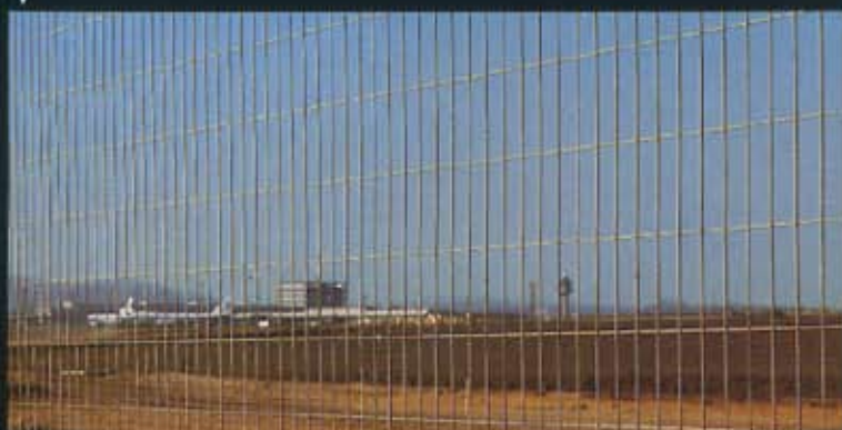
AEROPORTO INTERNACIONAL DE CUMBICA - GUARULHOS - SP. Delimitação e proteção de áreas (malha: 15 x 5 cm fio: 3,4 mm)
