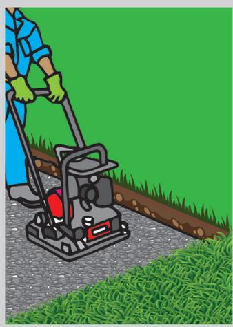
Todo o local a ser concretado deverá receber, no mínimo, 3 cm de brita 1. Esse cuidado deve ser observado mesmo que o solo esteja estabilizado, pois a forração ajuda a dissipar as forças de empuxo do lençol freático e a obter uma espessura homogênea na placa de concreto.
